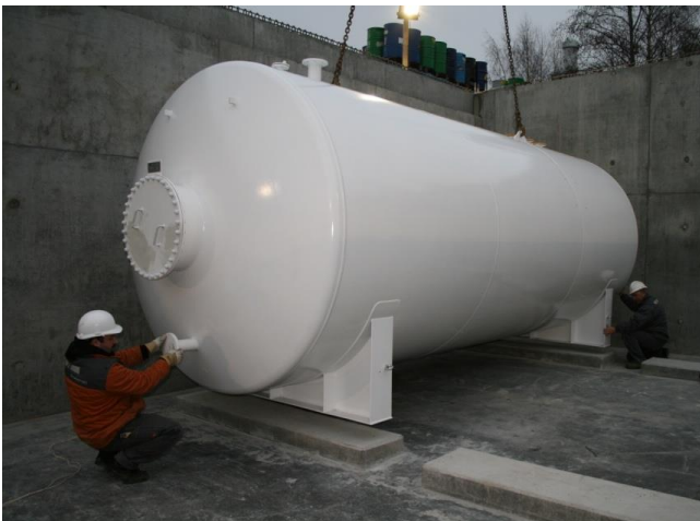
30 m 3 enkeltvægget tank med en diameter på 2,5 meter
