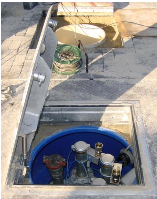
Kraftigt dæksel godkendt til 40 tons trafiklast.
