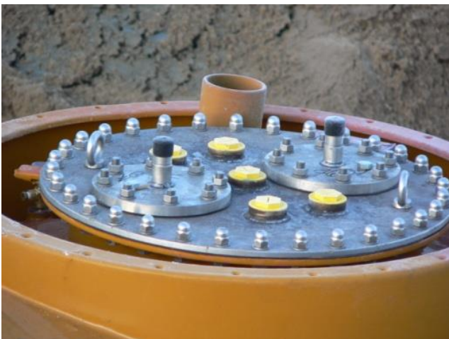
DN600 mandekarm med ramme for montage af nedstigningsskakt. Størrelsen af rammen tilpasses de forskellige modeller af skakte.
