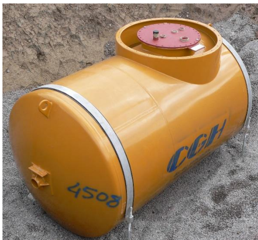
Förankring av en 5 m 3 underjord cistern med 2 stk. galvaniserade förankringsband och 4 stk. ingjutna ankare
