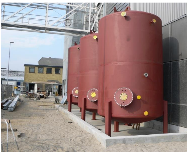
3 stk. 25 m 3 vertikale tanke med en diameter på 2900 mm
