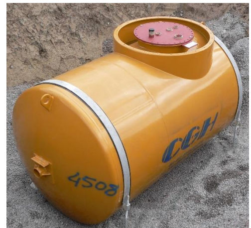
5 m 3 underjord cistern med ram för montage av nedstigningsschakt runt manluckan. Cisternen är säkrat med galvaniserade ankarband och förankringarna fastgjutna i bottenplattan.
