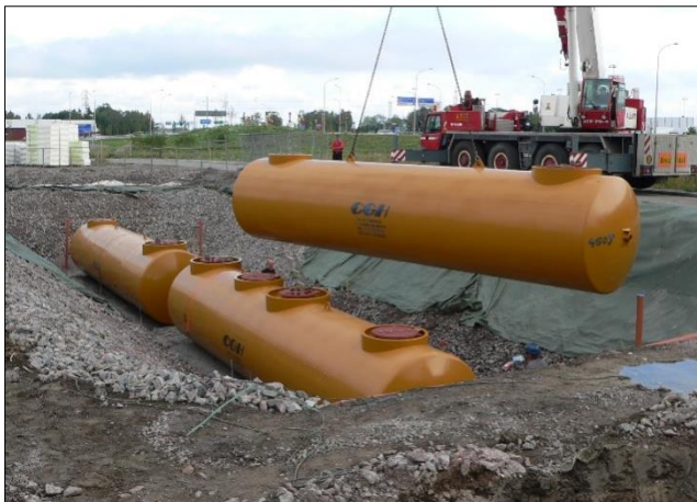
Installation av totalt 4 stk. 30 m 3 enkelmantlade underjord cisterner.
