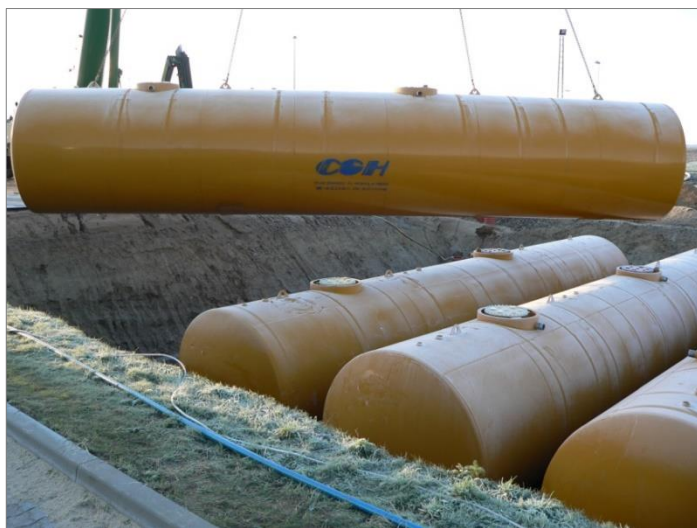
4 stk. 100 m 3 dubbelmantlade underjord cisterner med 2 fack.
