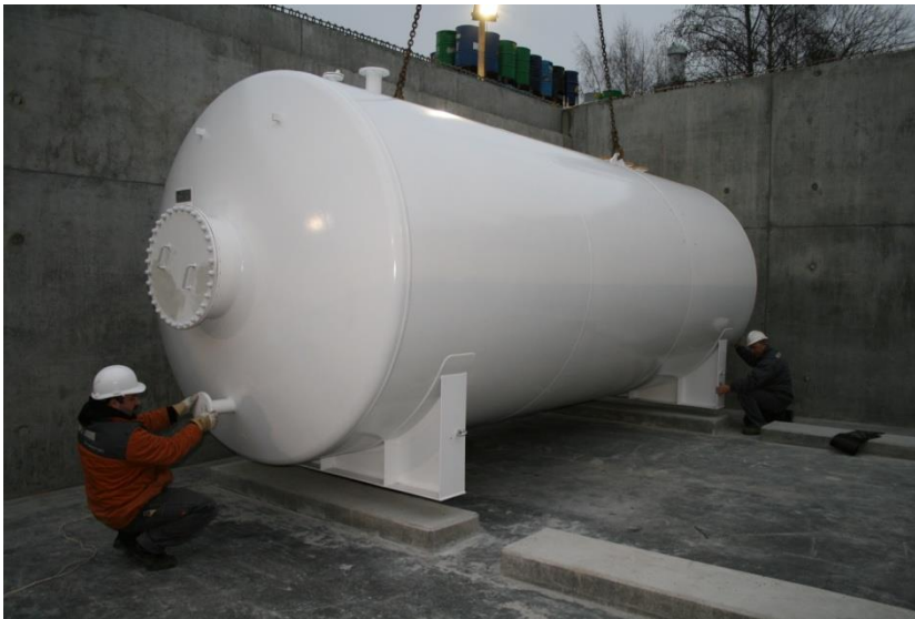
30 m 3 enkeltvægget tank med en diameter på 2,5 meter
