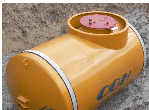
Förankring av en 5 m 3 underjord cistern med 2 stk. galvaniserade förankringsband och 4 stk. ingjutna ankare
