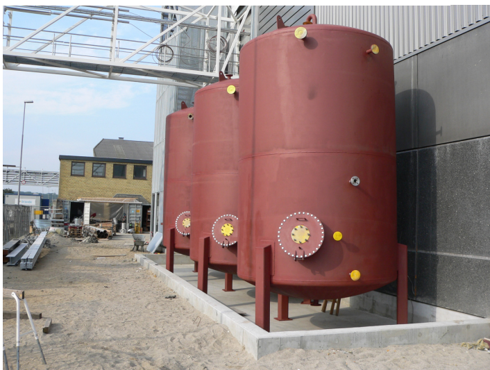
3 stk. vertikale tanke på hver 25 m 3 med en diameter på 2900 mm
